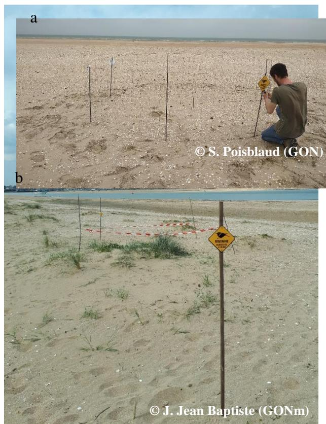
**Figure 18 : a) installation d'un enclos de protection « réactif » aux Hemmes de Marck (62), composé de grillage ursos et soutenu par des fers à béton b) enclos de protection « réactif » installé ici à Houlgate (14) et composé de simples piquets avec de la rubalise**
